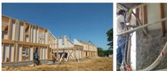
10 logements individuels groupés en béton de chanvre Les Loges en Josas, livré en 2015
