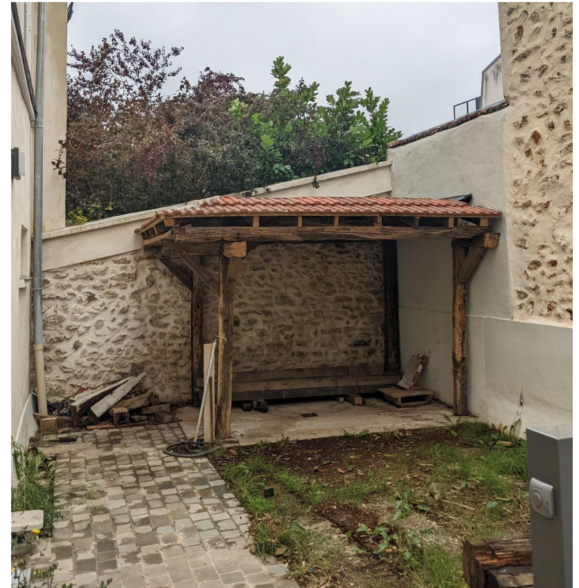
Appentis réalisé sur place_le Charpentier volant
