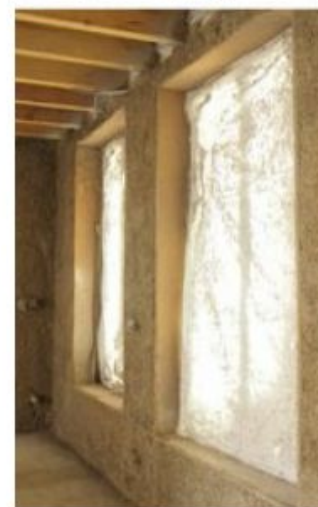
Réhabilitation d'un immeuble XVIIIe en béton de chanvre Paris, livré en 2016
