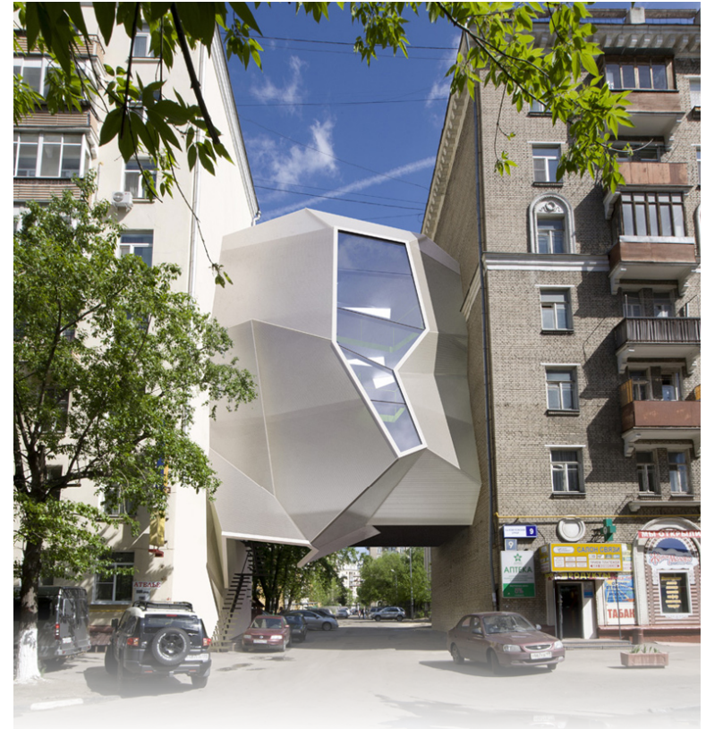
Parasite office à Moscou Architecte: Za Bor
