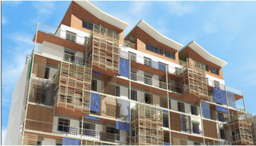
réhabilitation d'un immeuble de logements collectif à Paris Architecte: François Pelegrin
