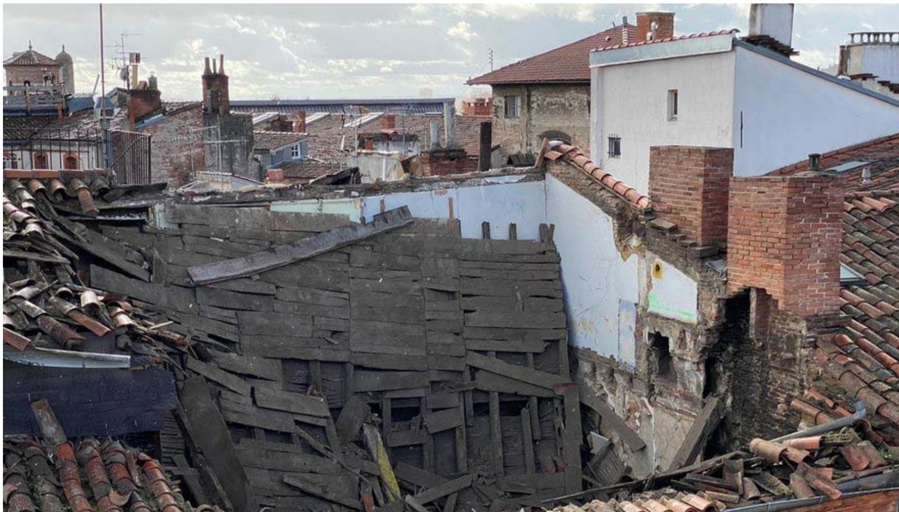
En 2019, rue Cujas (Toulouse), le toit d'un immeuble inoccupé s'effondrait sur les étages inférieurs, provoquant l'évacuation de quatre autres bâtiments adjacents
