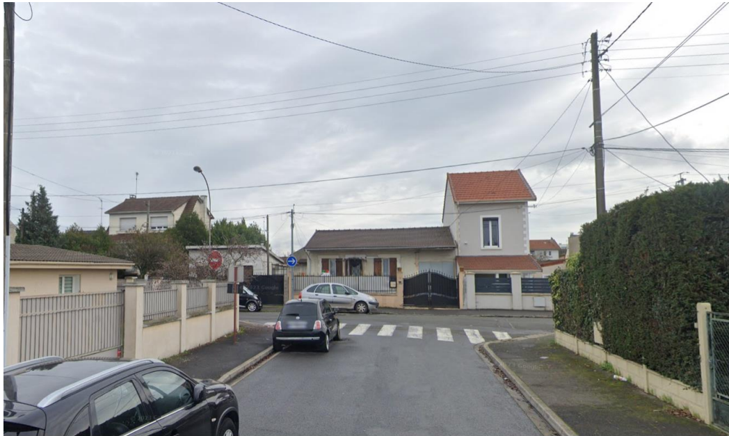
Existant : 2 pavillons dégradés
