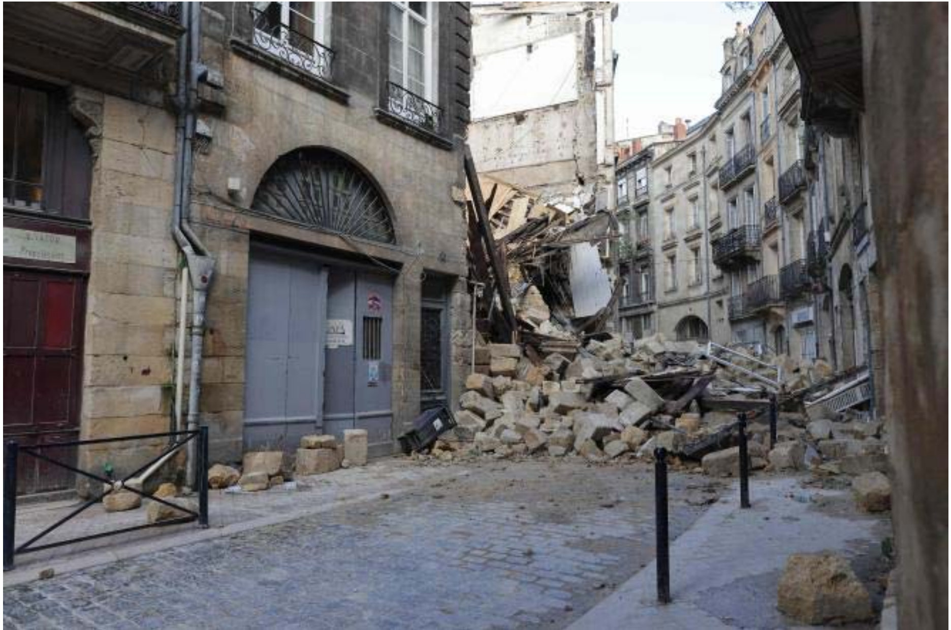
Bordeaux - Juin 2021 , deux immeubles dans le quartier Saint-Michel à Bordeaux se sont écroulés (sans faire de victime), puis non loin de là deux autres immeubles de trois étages se sont effondrés aux numéros 19 et 21 rue de la Roussel (centre ancien de Bordeaux = 3 personnes blessées / 1 était vide et en travaux et l'autre a été évacué in extrémis)
