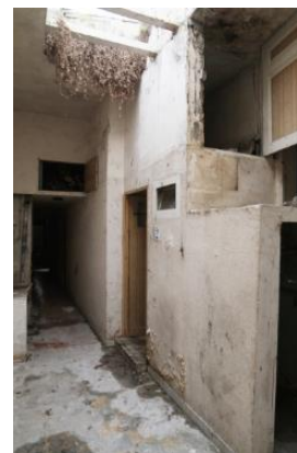
des logements aveugles en RDC
