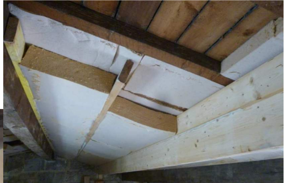
Isolation combles laine de bois Renforts de la charpente
