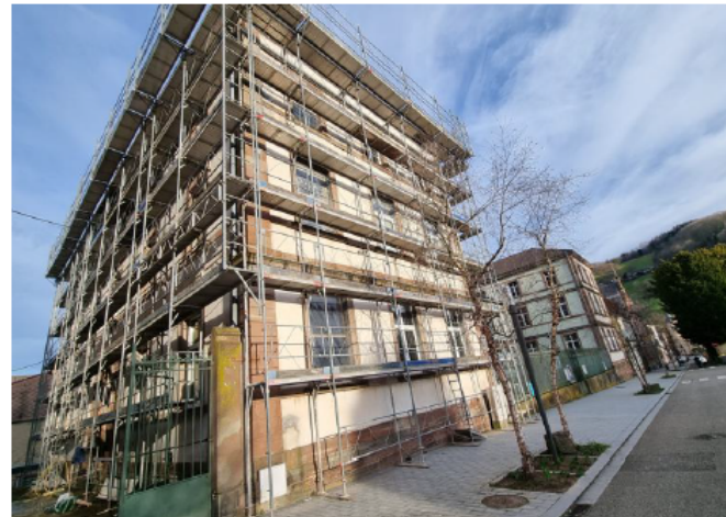
Rue Narbey, l'aile nord de l'école André-Aalberg s'est recouverte d'échafaudages. Photo Anne Muller
