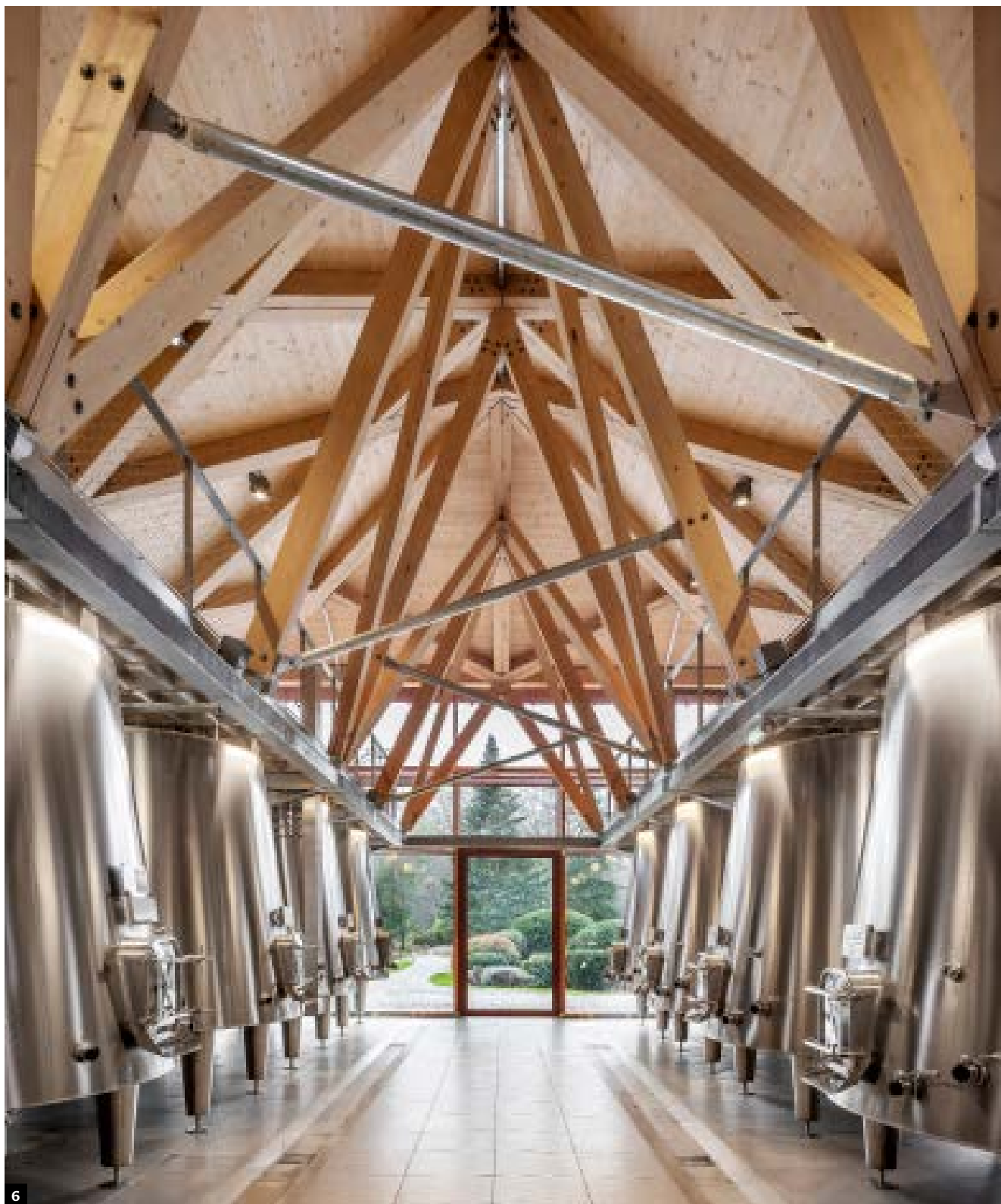
4 - Dans le chai à barriques, des compas métalliques supportent la voûte. Tous les produits mis en oeuvre ont été vérifiés par Excell, un laboratoire spécialisé dans l'analyse des vins. 5 - Signature visible depuis la route, le pisé a été retenu pour ses qualités écologiques et sa participation à l'image de marque. 6 - Le nouveau cuvier fonctionne en processus gravitaire avec l'aide de cuvons ascenseurs.
