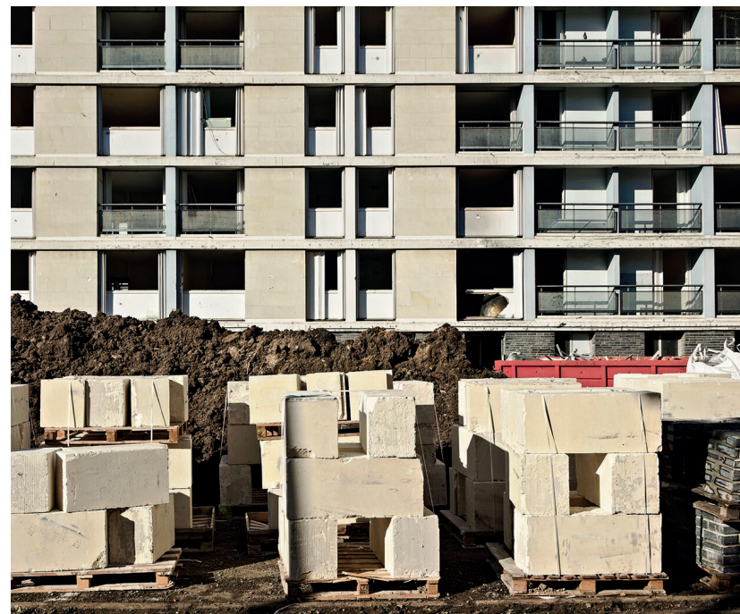
Réemploi de 360 mètres cube de façades autoportées en pierres massives de tuffeau sur un chantier à Tours FR . © F.Paillet - Tours Habitat
