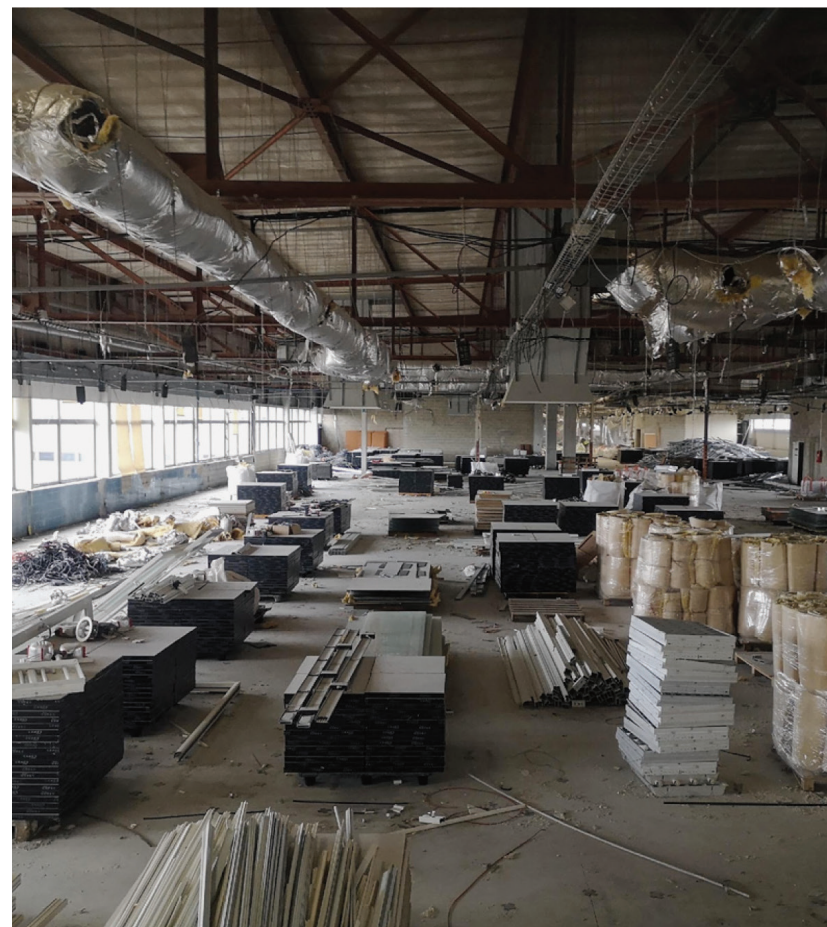
Récupération des éléments intérieurs des bureaux du Centre National des Arts Plastiques (Pantin FR ) en vue d'un réemploi hors-site. © Bellastock
