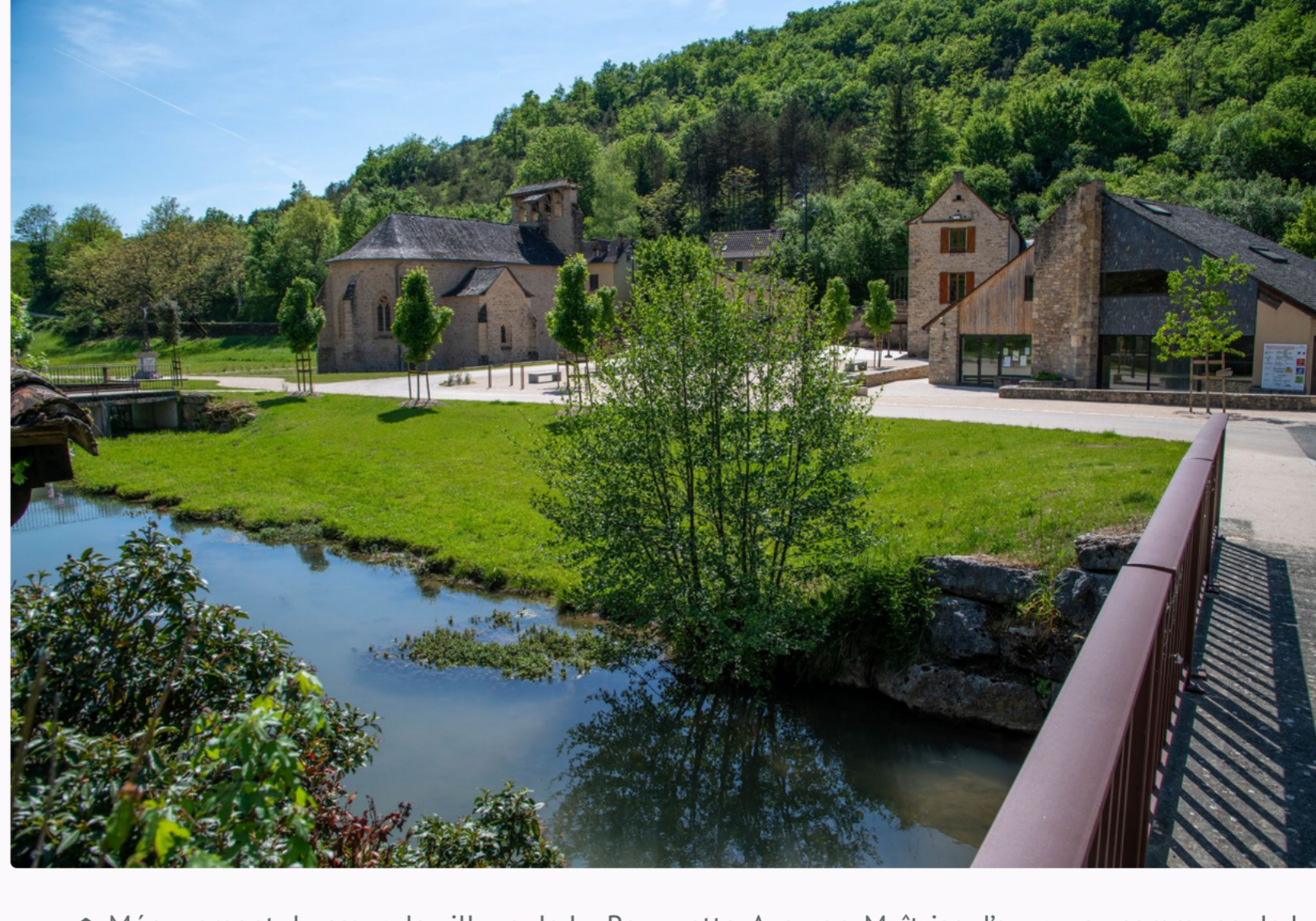
↑ Ménagement du cœur de village de La Rouquette, Aveyron. Maîtrise d'ouvrage : commune de La Rouquette. Maîtrise d'œuvre : Alain Marty (architecte) et Guillaume Laizé (paysagiste) © Alain Marty/Guillaume Laizé
