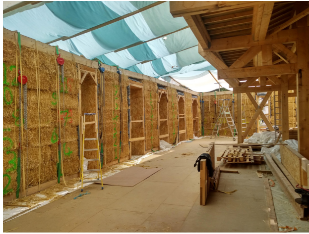
Fig. 4: Centre de loisirs under construction © Ville de Rosny-sous-Bois
