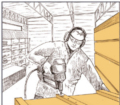
LES CAISSONS PRÉFABRIQUÉS SONT FERMÉS PAR DES PANNEAUX DÉRIVÉS DU BOIS.
